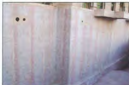
北京奥运村（B、D区）立墙防水工程
