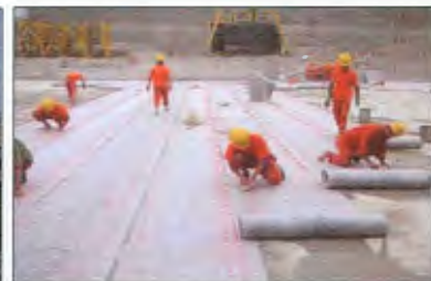
北京奥运村（B、D区）地下室防水工程
